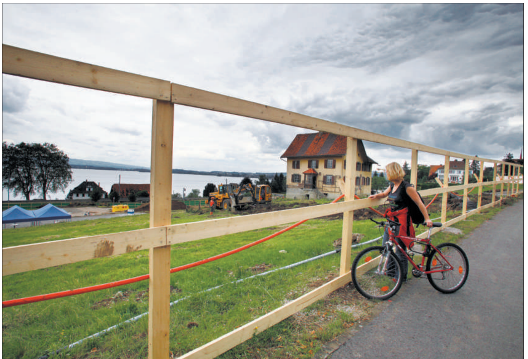
Herrlicher Bauplatz: In zweieinhalb Jahren geniessen die Bewohner der Häuser, mit deren Bau nun begonnen wird, diese atemberaubende Aussicht. BILD STEFAN KAISER
