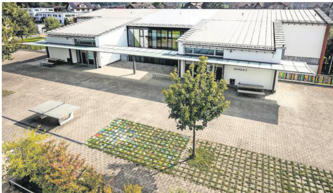
Die Rotkreuzer Schulgebäude aus den Jahren 1959 und 1964 bekamen einen neuen Anstrich und bunte Glasfenster. pd
