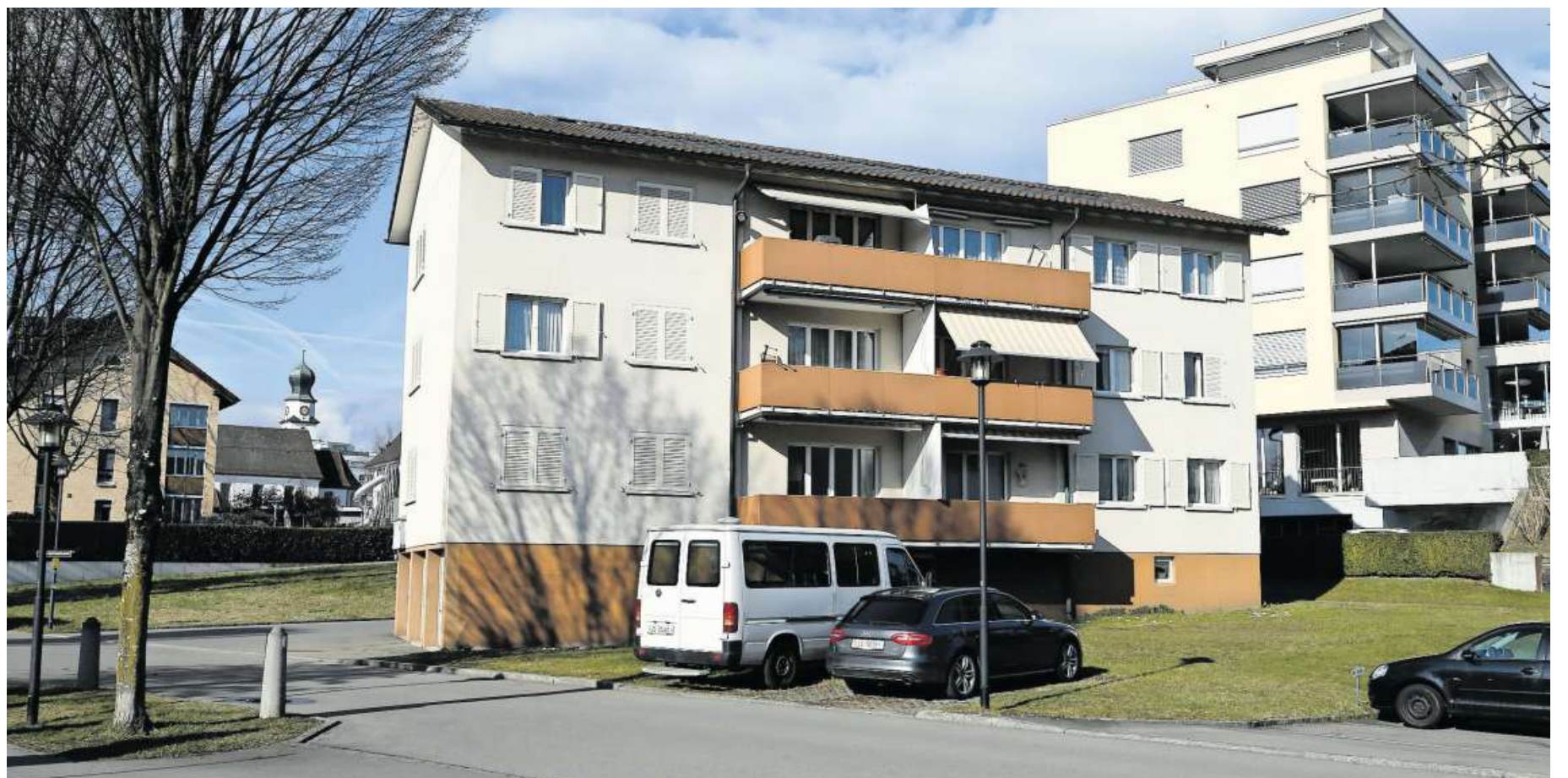
Das Haus an der Goldermattenstrasse 25 soll abgerissen und neu aufgebaut werden. Es sollen neun preisgünstige Wohnungen entstehen.
