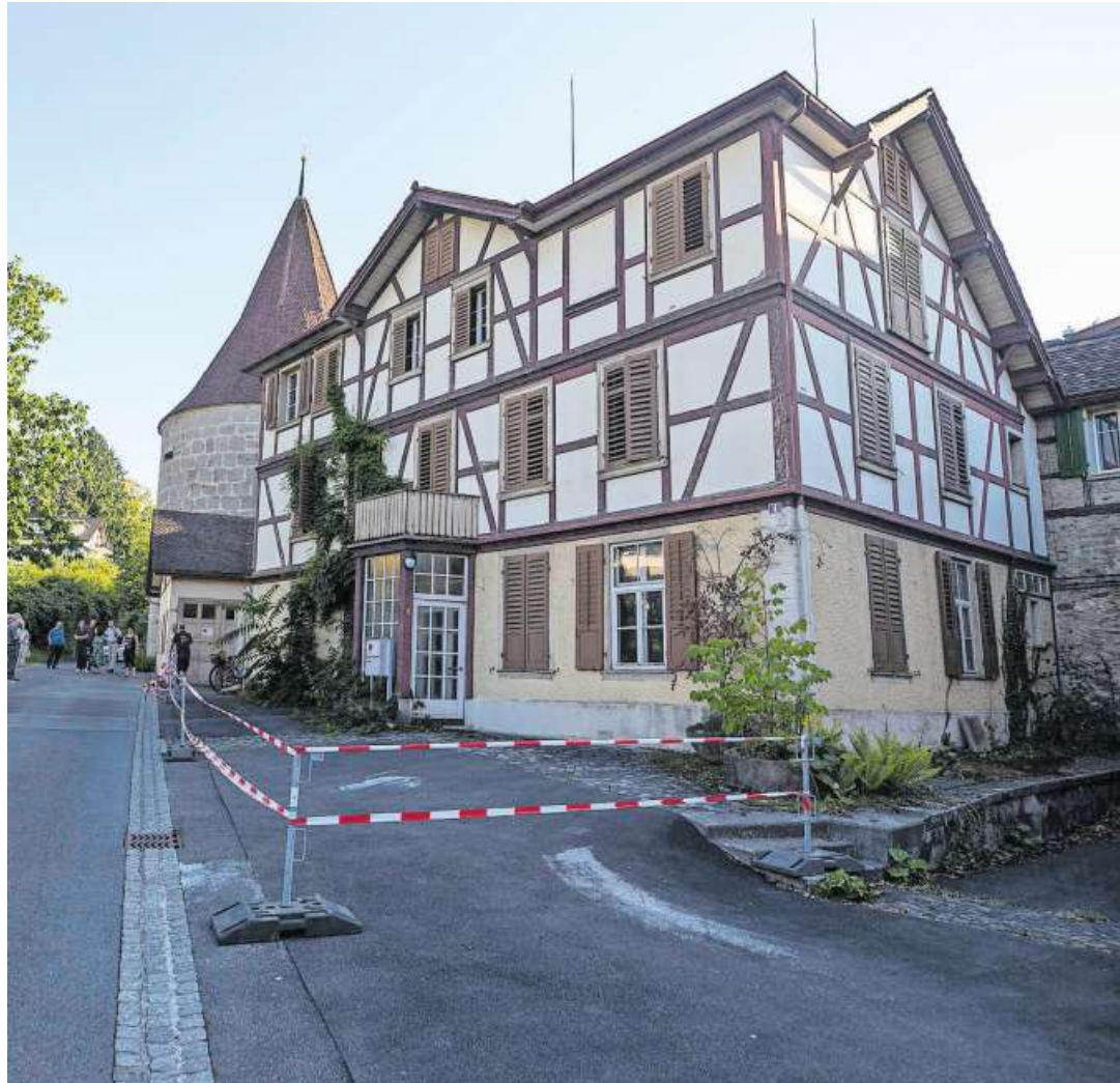
Die Gewoba Genossenschaft will die Häuser 4 und 6 am Knopfliweg sanieren. Im Bild das Haus Nr. 4.
