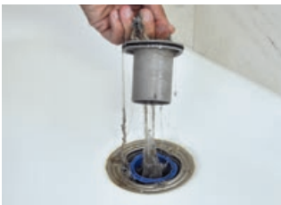
2 Sifoniereinsatz am Bügel herausziehen
