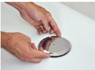
1 Sifonabdeckung entfernen
