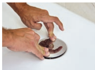
9 Sifonabdeckung einsetzen
