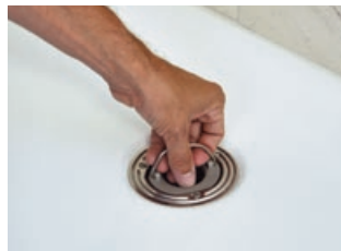
7 Sifoniereinsatz einsetzen
